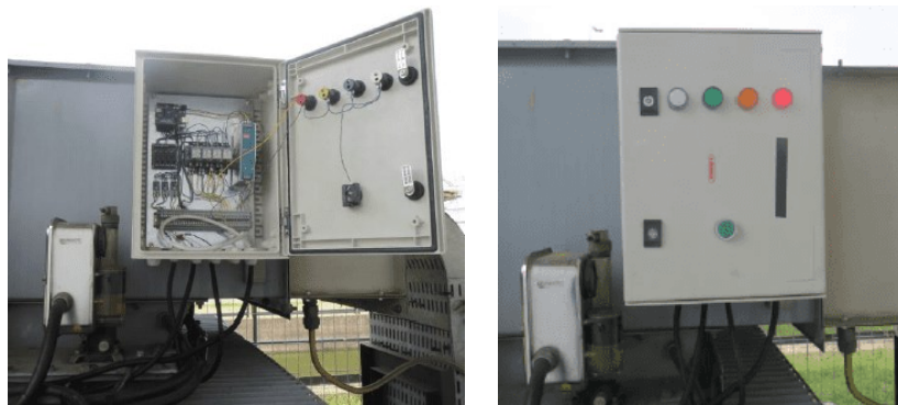
Gambar 10. Instalasi Rangkaian Menggunakan Box Panel di Transformator
