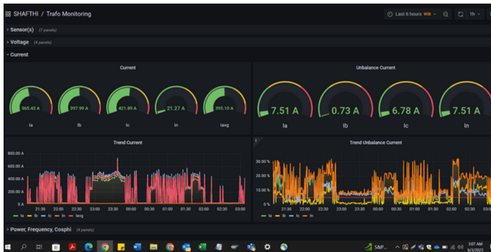
Gambar 13. Pembacaan Nilai Arus Transformator
