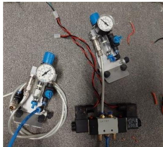
Gambar 8. Pengujian Manual Katup 5/2
