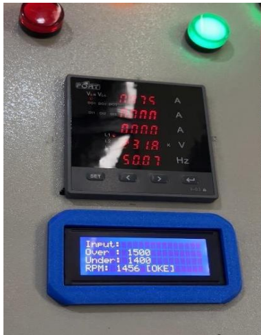
Gambar 10. Tampilan LCD ketika motor berputar pada kecepatan normal
