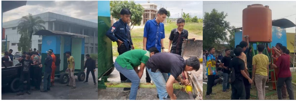
Gambar 3. Proses pengantaran dan instalasi MCK portabel di lokasi bantuan
