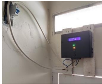
Gambar 10. Pemasangan Alat Monitoring Daya Listrik Pada Rumah Tangga
